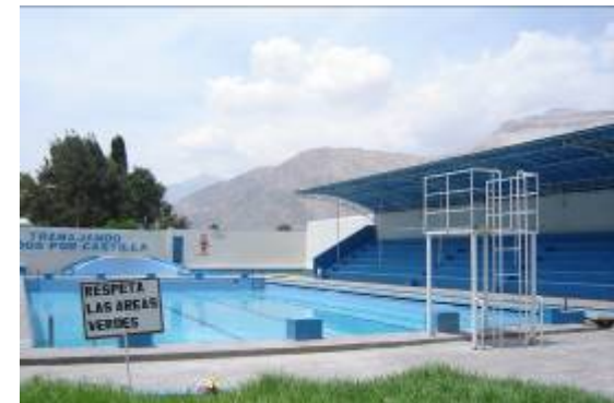
Mejoramiento de piscinas S/. 100,000
