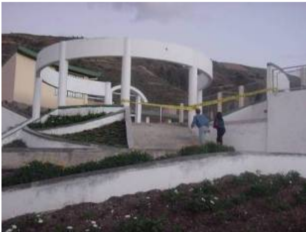
Construcción de piscina municipal S/. 1,566,535
